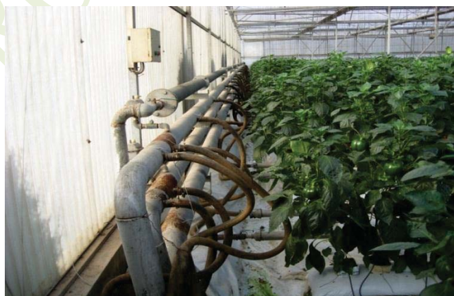
شکل ۱- استفاده از سامانه حرارت مرکزی از نوع آبگرم در گلخانه تولید فلفل
